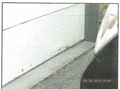
2028 - Garage door paint.
